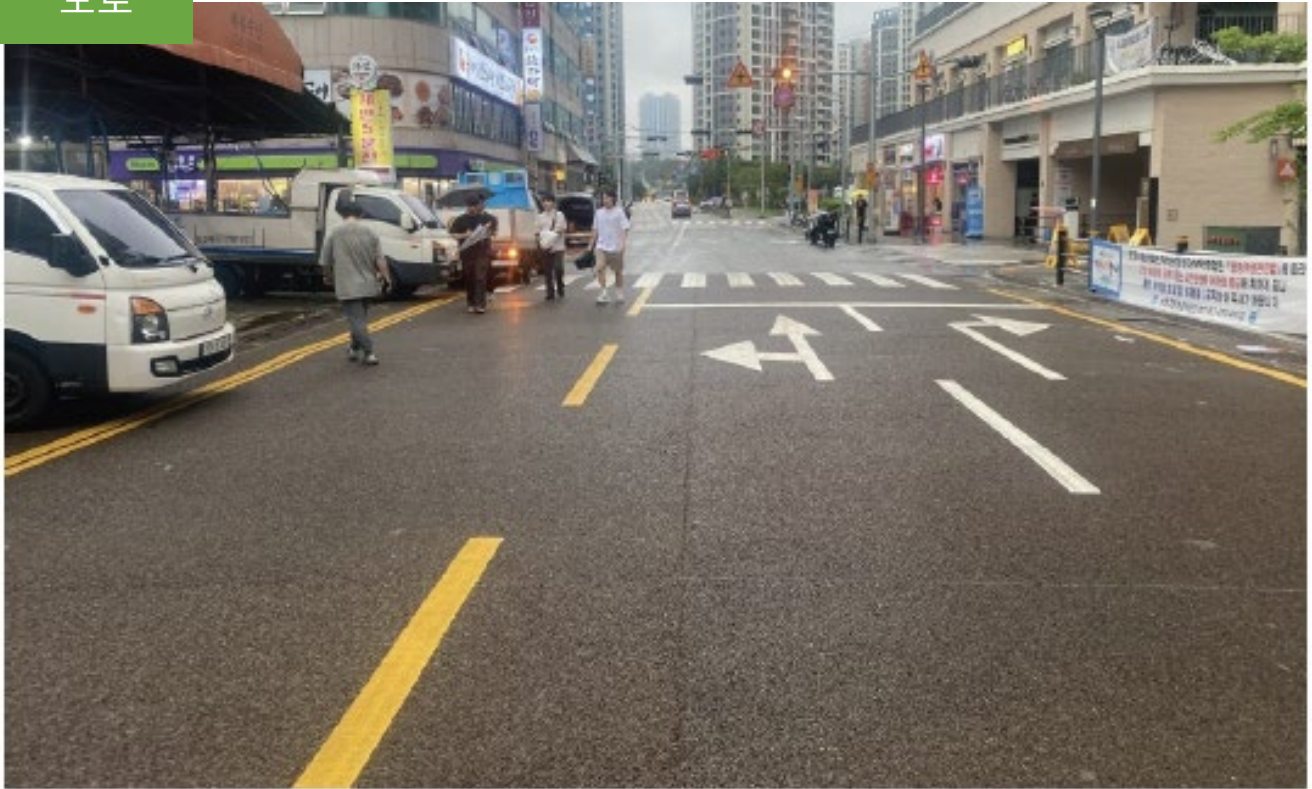
부산 수영구 민락동 도로 정비공사
