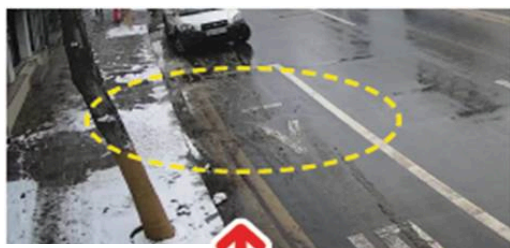
아스콘 포장 도로
