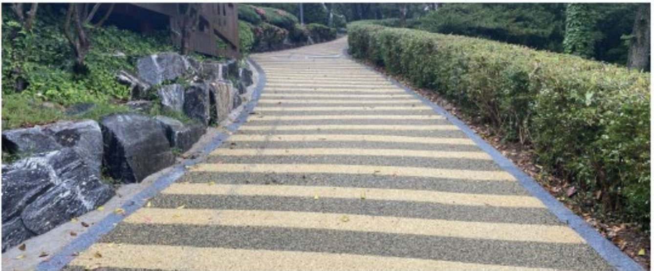
부산 해운대 달맞이길 산책로 정비공사
