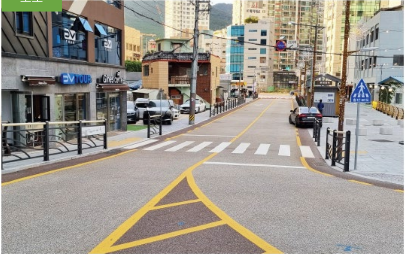
부산 동래구 온천장로 중앙대로 도로정비공사
