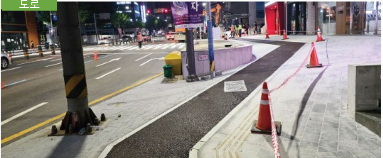
부산 수영구 대연동 77일원 보도 정비공사
