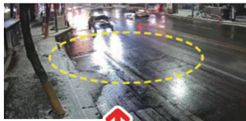
아스콘 포장 도로
