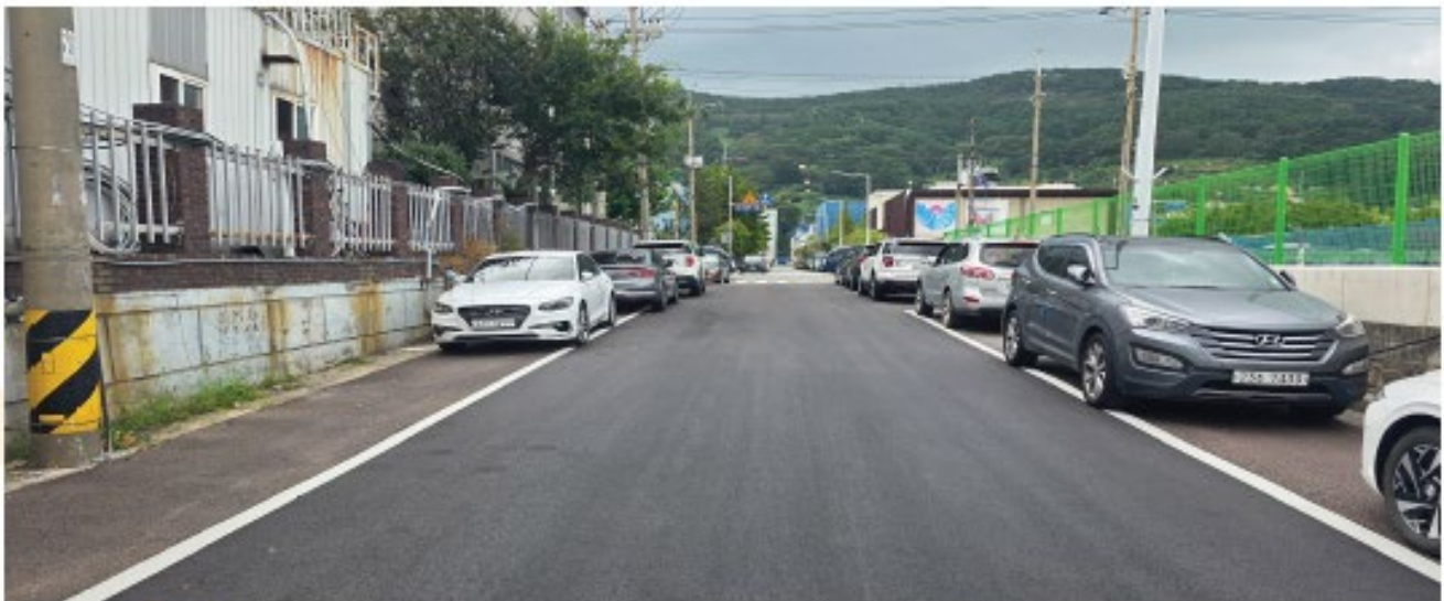
부산 사하구 신평장림 저탄소 조성공사
