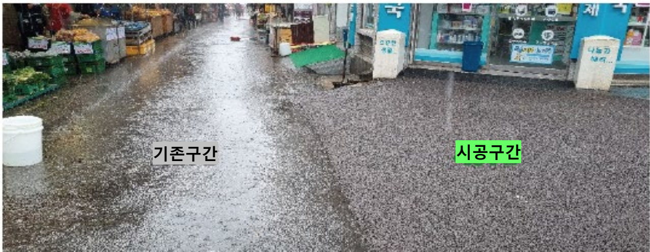
부산 동래구 동래시장 보도 정비공사
